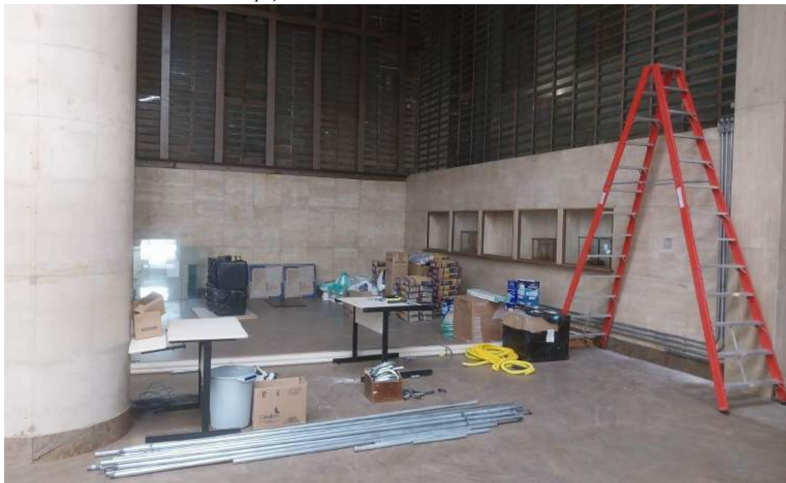
Foto 11: Espaço em obras da Gibiteca da futura sede da BPIJ-BH.
